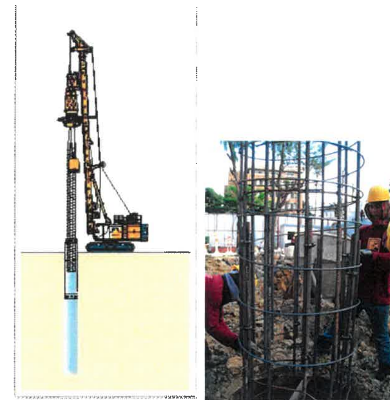
ขั้นตอนที่ 3 นำเหล็กเสริมที่ขึ้นรูปพร้อมแนวมัดติดลงไปในหลุมที่เจาะเตรียมไว้ โดยที่รอยต่อระหว่างเหล็กเสริมแต่ละท่อนต้องมีการขมวดอย่างเพียงพอและใช้มวนยึดหรือใช้ยึด (Clamp)
