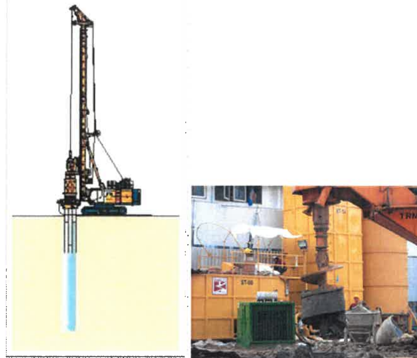
ขั้นตอนที่ 2 เจาะดินออกผ่านชั้นดินเหนียวอ่อนโดยใช้หัวเจาะแบบสว่าน (Auger) เมื่อได้ระดับความลึกก่อนทิ่มปลายปลอกเหล็กกับผิวสารละลายเบนโทไนท์ หรือ โพลีเมอร์ ที่มีคุณสมบัติตามข้อกำหนด เพื่อขุดและป้องกันหลวมจากทั้งชั้นจะเจาะผ่านปลายของปลอกเหล็ก แล้วเปลี่ยนหัวเจาะเป็นแบบถังเจาะกับดิน (Bucket) แล้วทำการเจาะลงไปจนถึงระดับที่ต้องการ โดยต้องรักษาระดับของสารละลายขุดหลุมจะให้น้ำต่ำกว่าระดับดินเดิมเกิน 3 เมตร
