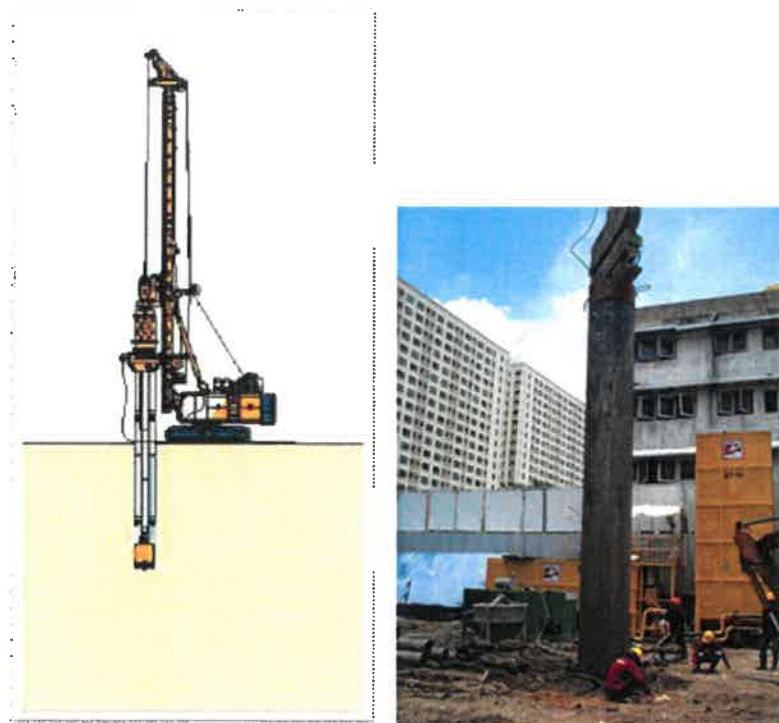
ขั้นตอนที่ 1 ดำรงจากแท่นตำแหน่งเดิม กดปลอกเหล็ก (Steel Casing) ลงดินใต้อยู่ในตำแหน่งโดยใช้ไวโรโบรมเมเจอร์ โดยปลอกเหล็กที่ใส่จะมีความยาวตลอดช่วงความลึกของชั้นดินอ่อน
