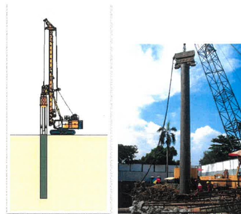
ขั้นตอนที่ 5 ถอนปลอกเหล็กออกโดยใช้ไวโรโบรมเมเจอร์
